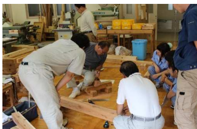
1 大工(建築大作業)指導風景
